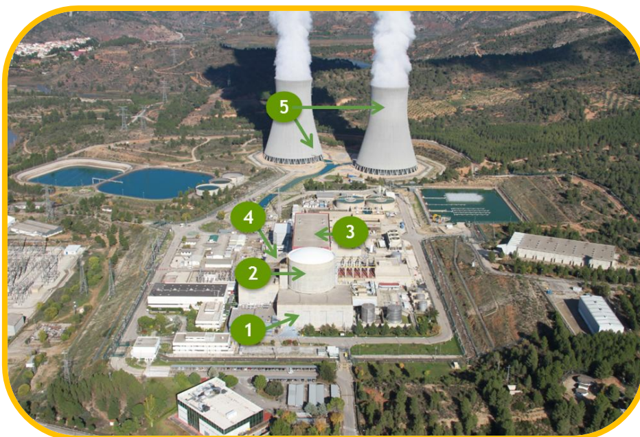
Figura 5. Edificios principales C.N. Cofrentes.
